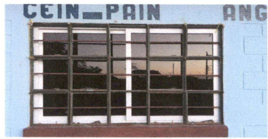
Foto 2: Sustitución de ventanas
