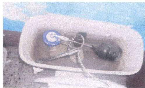
Foto 4: Sustitución de accesorios en inodoros
