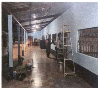
Foto 3: Aplicación de pintura en muro interiores y exteriores
