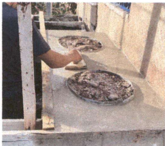
Foto 5: Instalación de lavamanos
