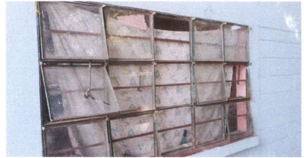
Foto 2: Sustitución de ventanas
