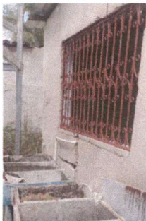
Foto 5: Instalación de lavamanos
