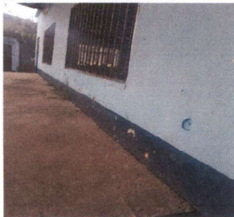
Foto 3: Aplicación de pintura en muro interiores y exteriores
