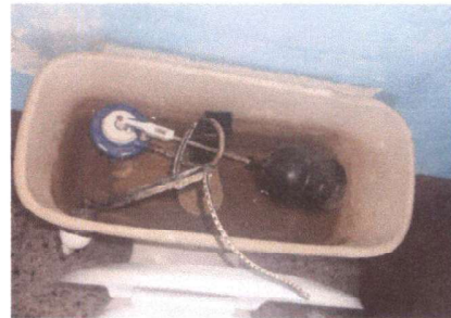
Foto 4: Sustitución de accesorios en inodoros
