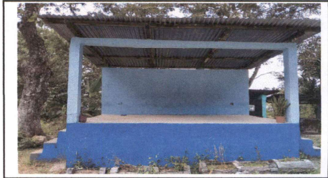
Foto 2: Remodelación de techo y amplitud con estructura de metal
