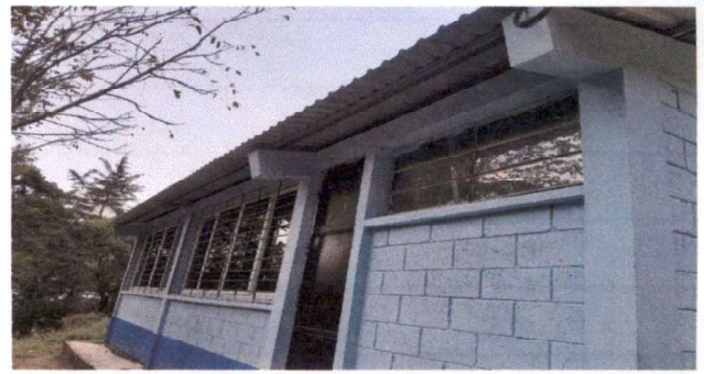
Foto 10: Instalación de balcones de metal
