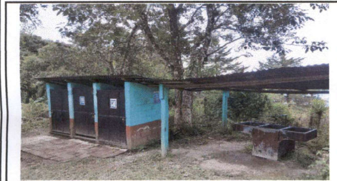
Foto 3: Cambio de estructura del área de la pila
