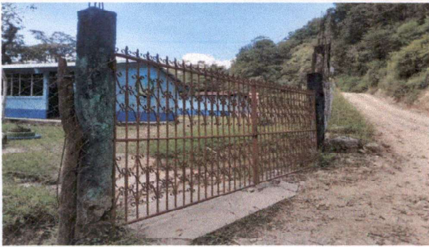
Foto 7: Cambio de porton
