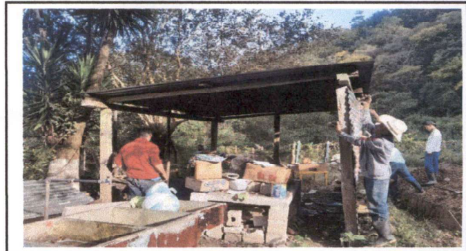
Foto 4: Cambio de lámina del área de la pila
