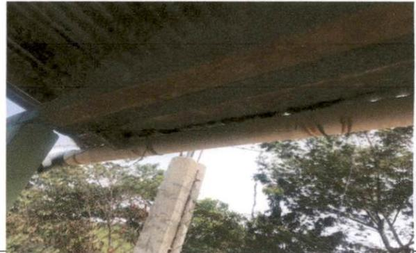
Foto 6: tubos de drenaje de lluvias
