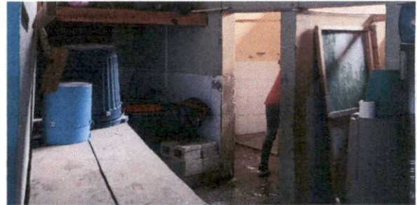
Foto 6: reparacion completa de la area de baños
