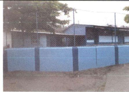
Foto 2: Reparación de malla galvanizada finalizada
