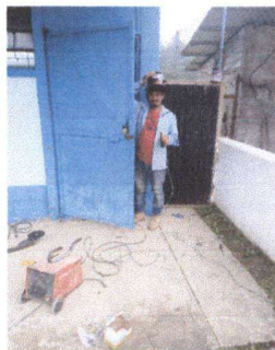
Foto 5: Proceso de sustitución de chapas
