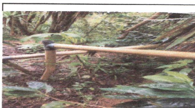
Foto 4: Sustitución de tubería PVC línea principal aguas negras (3 pulg o 4 pulg)
