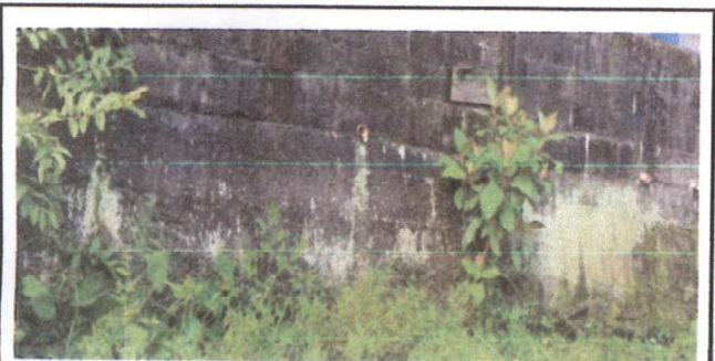
Foto 5: Reparación de muro perimetral de block.
