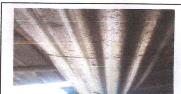
Foto 6: Sustitución de canal de metal
