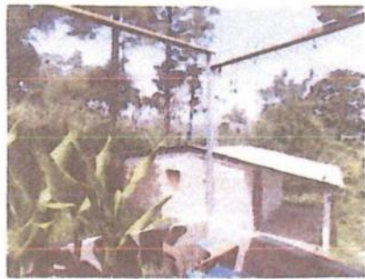
Foto 5: Muro perimetral parte posterior del establecimiento
