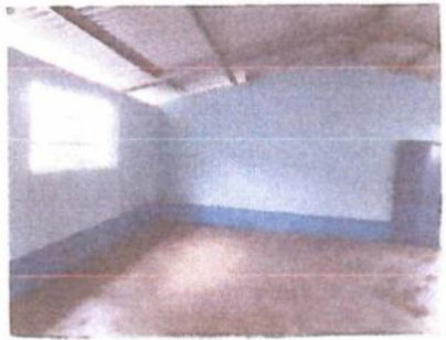
Foto 1: Pintura interior del aula
