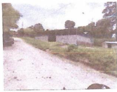
Foto 4: Muro perimetral parte frontal
