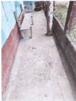
Foto 11: Torta de cemento del corredor que comunica con los baños agrietada.
