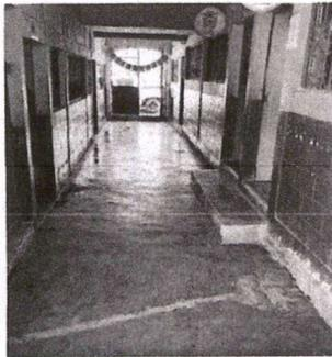
Foto 3: SUSTITUCIÓN DE PISO DE CEMENTO LIQUIDO.
