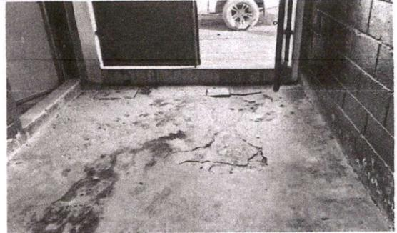
Foto 2: SUSTITUCIÓN DE PISO DE CEMENTO LIQUIDO.
