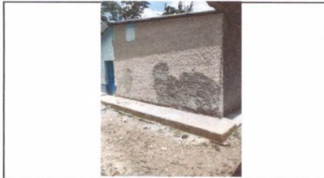
Foto 3: Remodelación de grietas y fisuras
