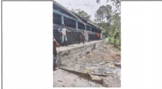
Foto 2: Remodelación de muro de contención
