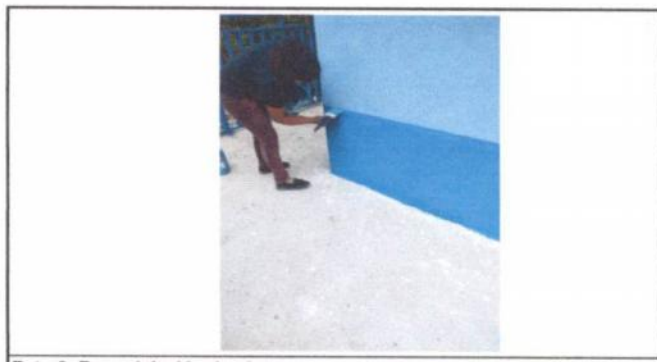
Foto 6: Remodelación de pintura
