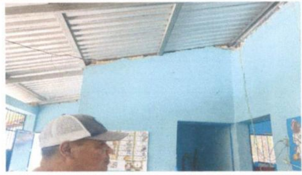
Foto 2: Cambio de cableado de energía eléctrica.
