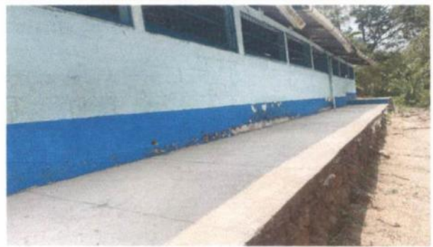
Foto 4: Colocación de baranda de hierro.
