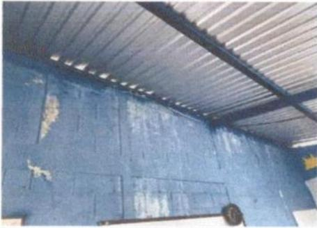
Foto 3: Estructura metálica limpia y pintada.
