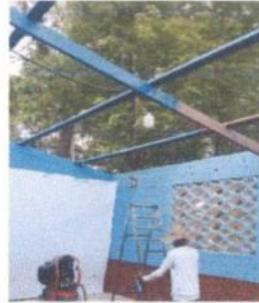
Foto 4: Limpiando, lijando y pintando con pintura anticorrosiva azul la estructura metálica del techo.
