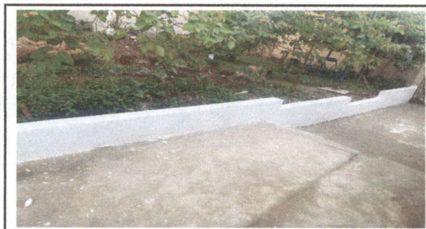
Foto 5: Muro de contención
