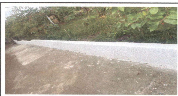
Foto 6: Muro de contención
