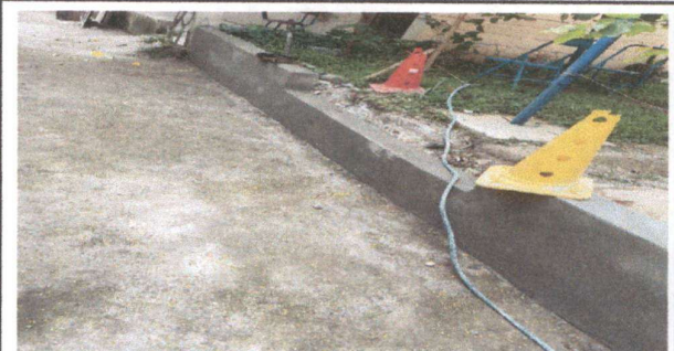
Foto 6: Muro de contención
