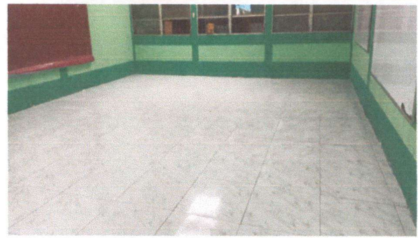
Foto 2: colocación de piso de salones terminado
