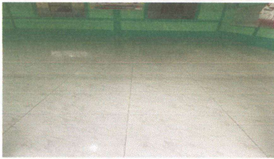
Foto 3: Colocación de piso en salones terminado
