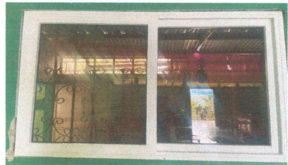
Foto 4: colocación de ventanas terminado
