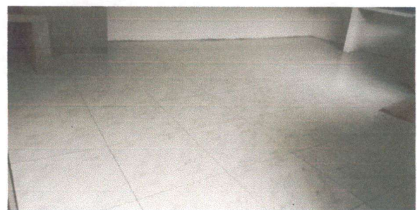
Foto 6: colocación de piso en cocina terminado
