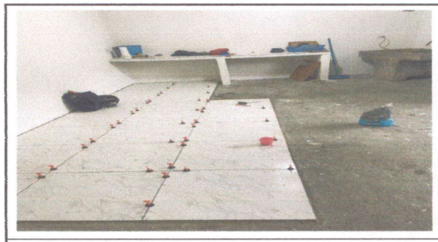
Foto 6: colocación de piso en cocina en proceso
