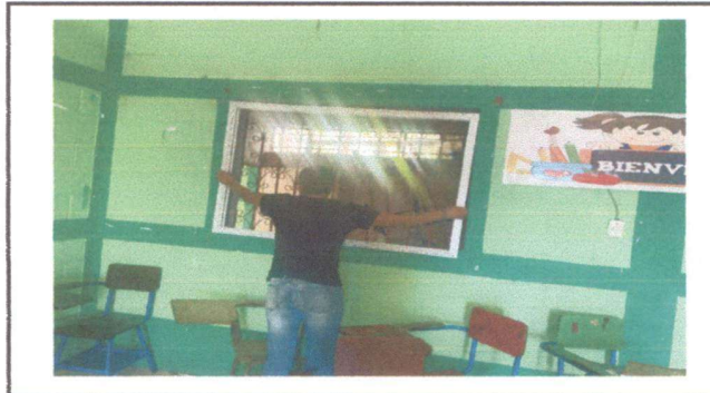
Foto 4: colocación de ventanas
