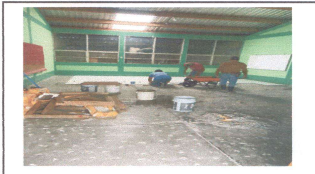
Foto 2: colocacion de piso de salones en proceso
