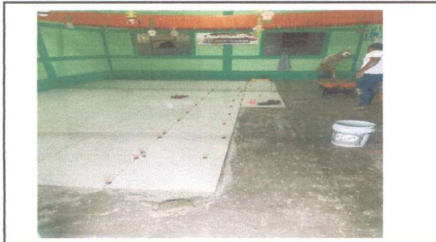
Foto 3: Colocación de piso en salones en proceso
