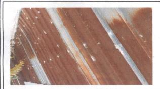
Foto1: MODULO CUBIERTA DE LÁMINA, lámina en mal estado
