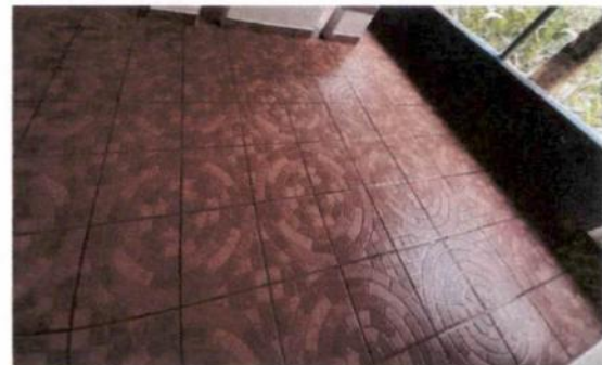
Sustitución de piso de granito
