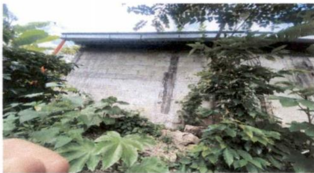
Reparación de muro perimetral de block
