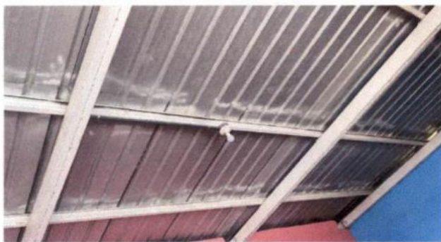
Reparación de cableado eléctrico
