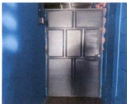
Sustitución de puerta
