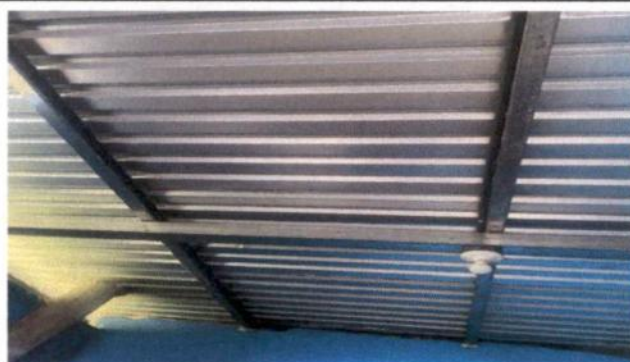
Sustitución de estructura de soporte (madera, metal) por metal
