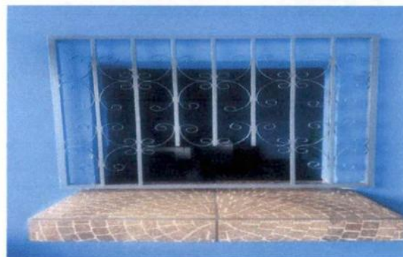
Sustitución de estructura de metal de ventana
