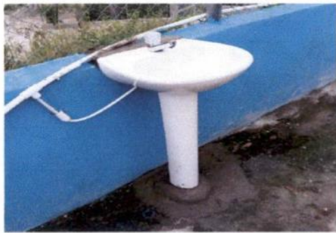
Sustitución de lavamanos
