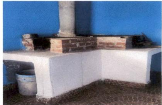
Reparación y sustitución del área de cocina
