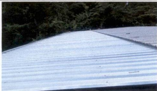
Sustitución de lámina, por lámina troquelada
