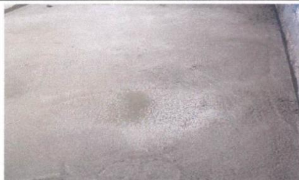
Sustitución de piso de torta de concreto
