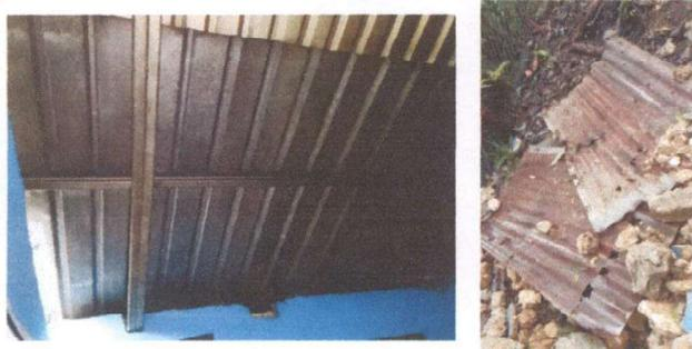
FOTO 11 SUSTITUCIÓN DE ESTRUCTURA Y LAMINA TROQUELADA
