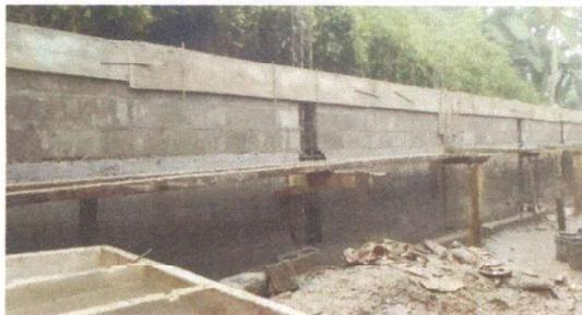
Foto 5: REPARACIÓN DE DE MURO PERIMETRAL, REPELLO Y CERNIDO
