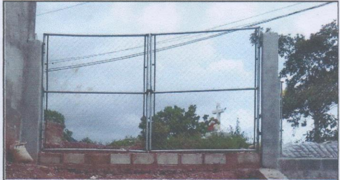
Foto 2: Porton Principal de maya y tubo galvanizados
