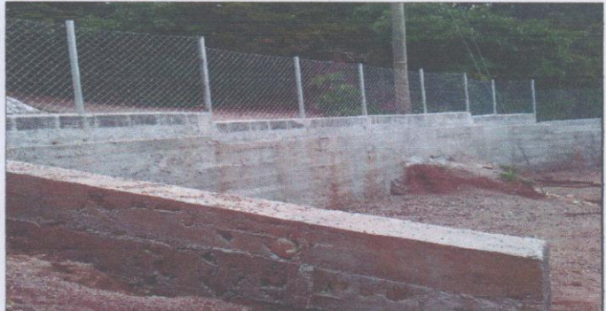
Foto 4: Muro Perimetral y Malla galvanizada
