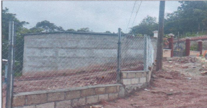
Foto 3: Muro Perimetral y Malla galvanizada exterior.
