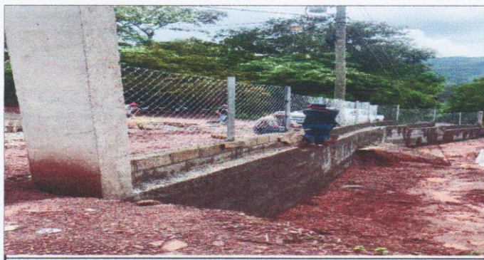
Foto 5: Colocacion de malla galvanizada.
