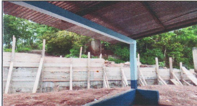
Foto 3: fundicion de muro de contencion.
