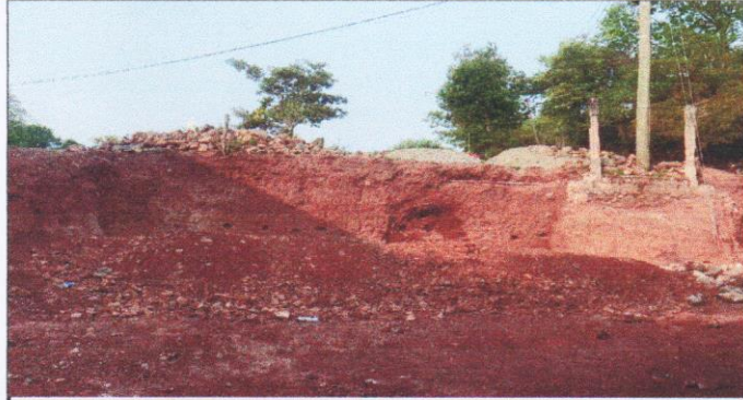
Foto 1: inicio de trabajos en muro perimetral
