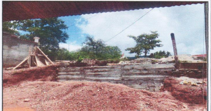
Foto 4: continuación de los trabajos en muro perimetral.
