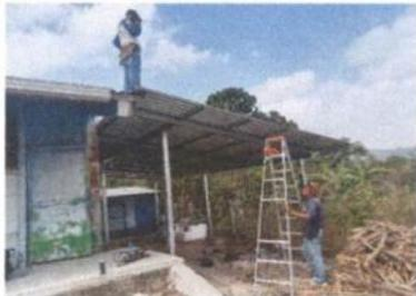
Foto1: Sustitución de lámina por lámina troquelada.
