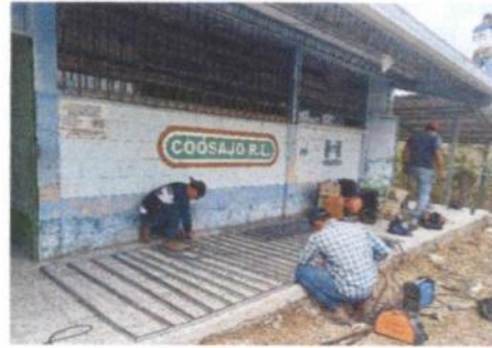
Foto 8: Sustitución de balcones
