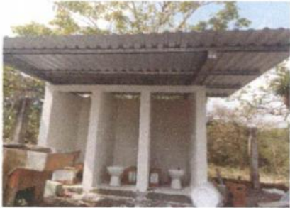
Foto 7: sustitución de inodoros.
