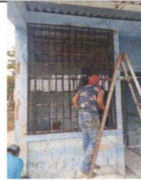
Foto 4: Sustitución de vidrios
