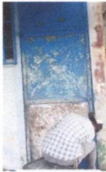
Foto 3: Mantenimiento a estructura, lijado, pintura y cambio de chapas.
