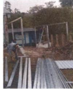
Foto 2: Sustitución de estructura de soporte, Madera por metal.
