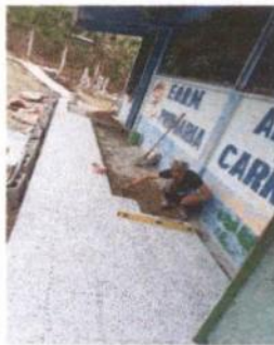
Foto 5: Sustitución de piso de granito
