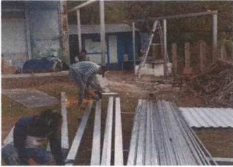
Foto 1: Sustitución de lámina por lámina troquelada.
