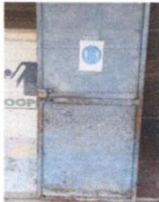
Foto 3. Mantenimiento a estructura, lijado, cepillado, sujeciones, aplicación de pintura.
