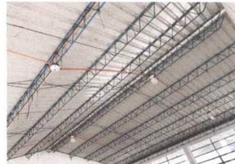
Foto 12: Reparación del sistema eléctrico (cables)
