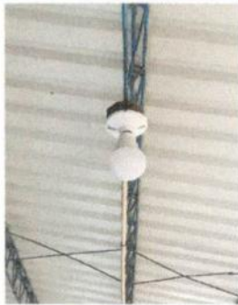
Foto 15: Sustitución de lámparas por bombillos led.
