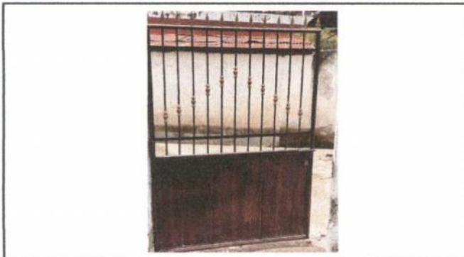
Foto 1: Puerta. (Sustitución de puerta)
