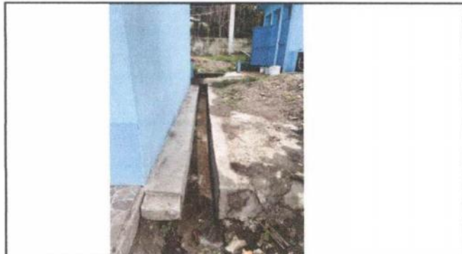
Foto 4: baja de agua pluvial.
