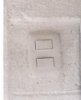
Foto 14: Sustitución de interruptores simples y dobles
