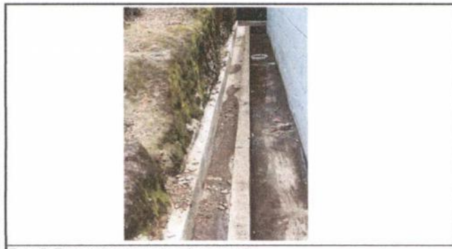
Foto 5: Banquetas y cunetas de concreto
