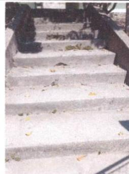
foto 6: reparación de gradas en mal estado y reparacion por la baja de agua de lluvia por las gradas
