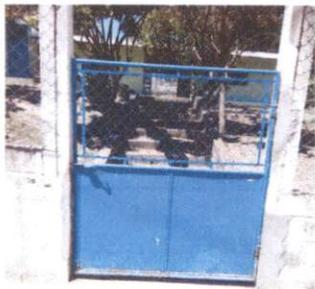
foto 11: sustitución de porton de entrada en mal estado y por uno mas alto para evitar que se ingresen por la parte de arriba
