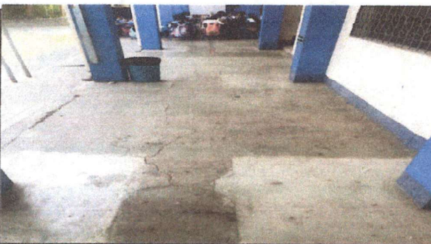
Foto 5: Se sustituirá el piso de concreto por granito, puesto que es un área que está pendiente de remozar ya que los otros pasillos son de granito.
