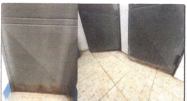
Foto 6: se remozará puertas por deterioro oxidado (lijado, cepillado y aplicación de pintura) para restaurar su funcionalidad.
