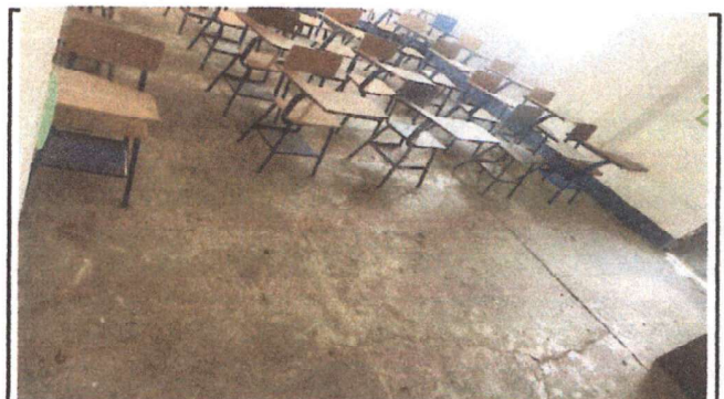
Foto 4: Se sustituirá el piso de concreto por granito, puesto que es el único salón que está pendiente de remozar ya que los otros salones tienen piso de granito.
