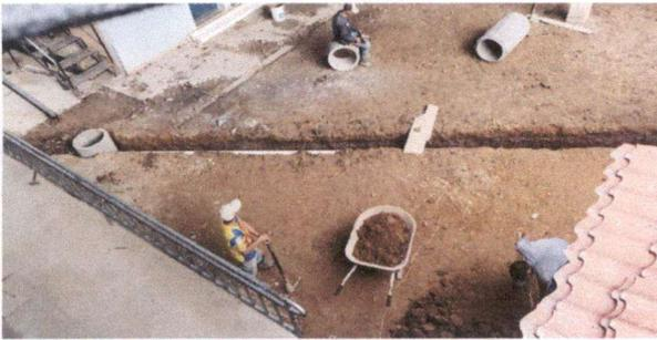
Foto 3: Sustitución de drenajes e instalación de cajas unificadoras.
