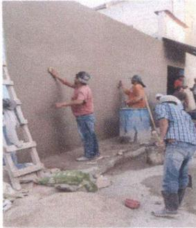
Foto1: Repello de muro exterior.
