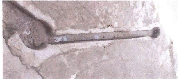
Foto 4: Sustitución de tubería de drenaje por estar deteriorada.
