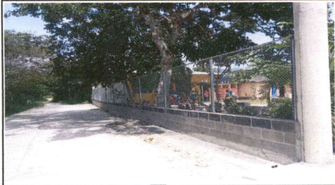
Foto 1: Muro Perimetral de 130 mt²
