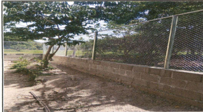
Foto 3: Muro Perimetral de 130 mt²
