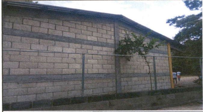
Foto 4: Muro Perimetral de 130 mt²
