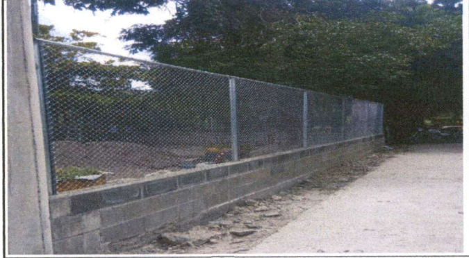
Foto 2: Muro Perimetral de 130 mt²
