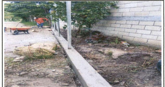
Foto 4: Colocación de Tubo Galvanizado
