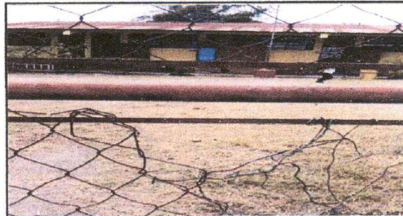
FOTO 2: PUERTA EN MAL ESTADO
