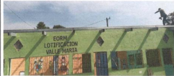
1. Cubierta de lámina: Sustitución de lámina, por lámina troquelada aluminio y zinc
