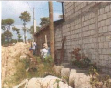
4. Muros Perimetrales: Reparación de muro perimetral de block (Repello)
