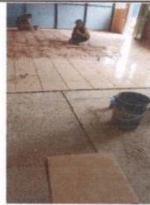
3. Piso: Sustitución de piso cerámico
