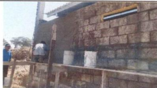
4. Muros Perimetrales: Reparación de muro perimetral de block (Repello)
