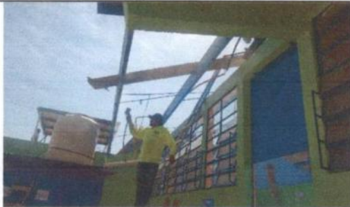
2. Estructura de techo: Mantenimiento a estructura de soporte de metal
