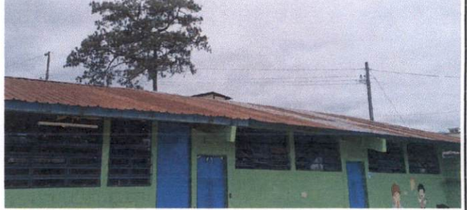
2 Estructura de techo
