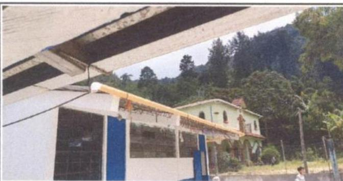
Foto 5: Sustitucion de Bajada de agua pluvial de metal por tubo pvc 4.
