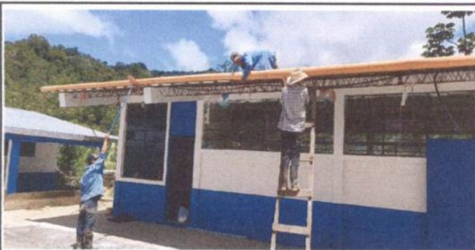
Foto 5: Sustitución de Bajada de agua pluvial de metal por tubo pvc 4.
