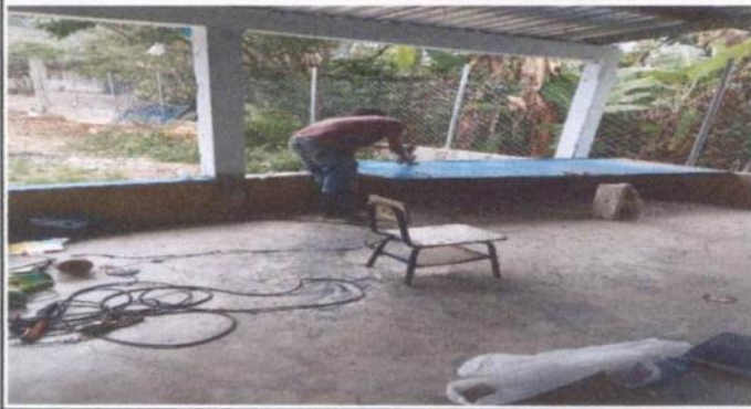
Foto1: Mantenimiento a Estructura de puertas de los baños, cocina, salones.
