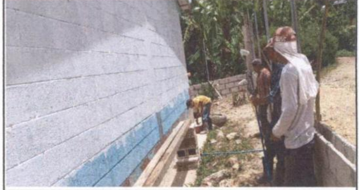
Foto 2: Pintura en muros exteriores e interiores
