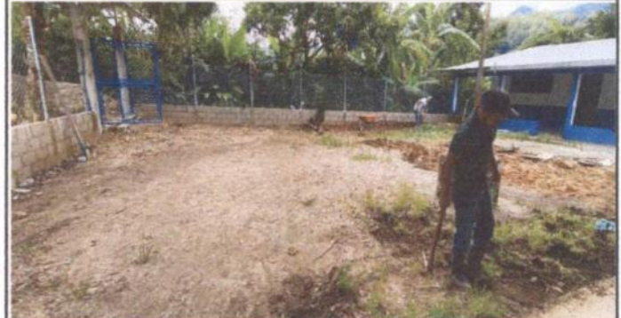
Foto 4: Reparacion de plancha de concreto
