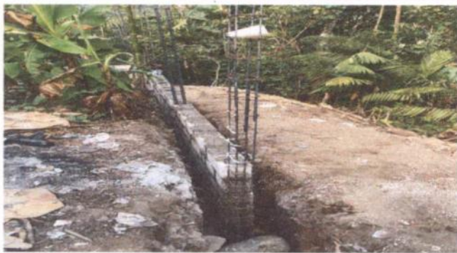
Foto 3: Reparación del Muro Perimetral
