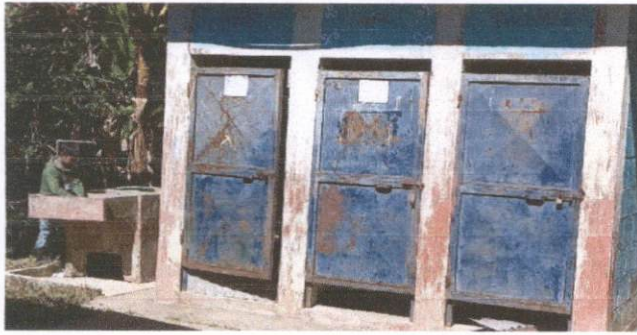
Foto 1: mantenimiento a estructura de puertas de los baños, cocina, salones.
