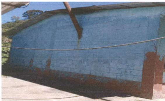
Foto 3: Pintura en muros exteriores e interiores.
