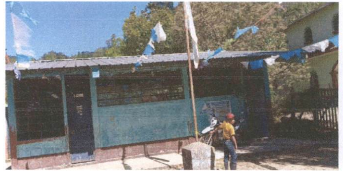
Foto 2: sustitución de vidrios.
