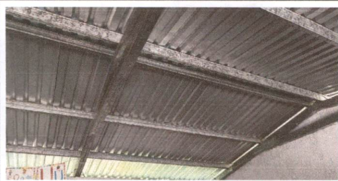
Foto 10: Sustitución de plafoneras
