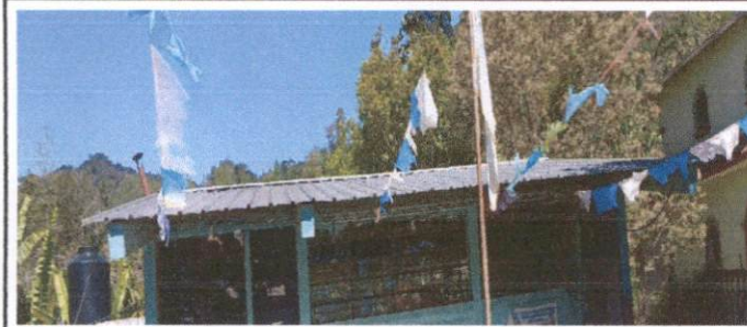
Foto 13: Sustitución de bajada de agua pluvial de metal por tubo PVC 3.
