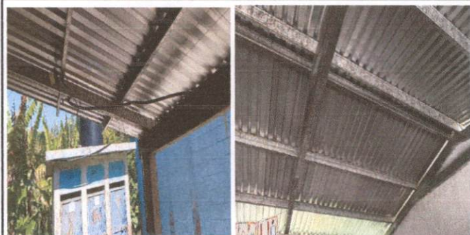
Foto 13: Reparación de cableado electrico.
