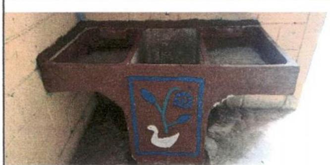
Foto 8: Sustitución de pila de cemento de dos lavaderos
