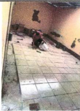
Foto 3: Sustitución de piso cerámico
