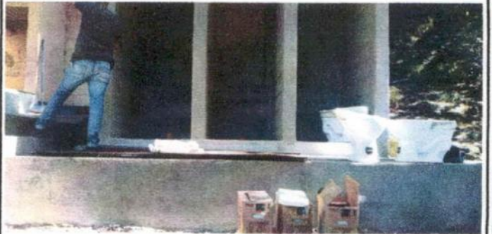
Foto 4: Sustitución de inodoros y sus accesorios
