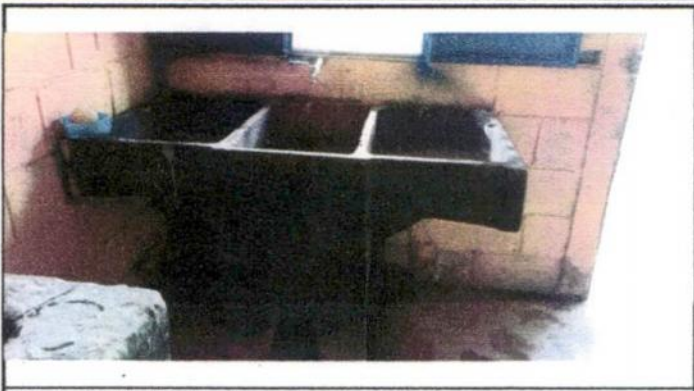
Foto 8: Sustitución de pila de cemento de dos lavaderos
