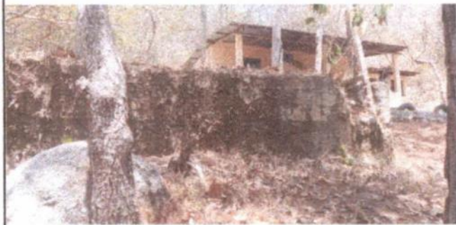
Foto 5: Reparación de muro de contención
