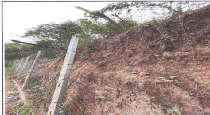
Foto 3: Area de Muro
