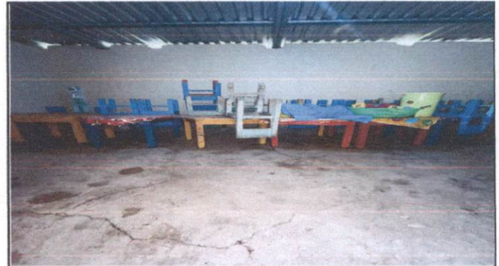
Foto 4: Reparacion de Piso
