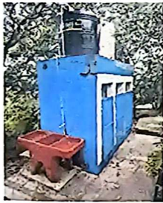
Foto 3: Tinaco y red de conexión de agua en proceso de mejora y ampliación
