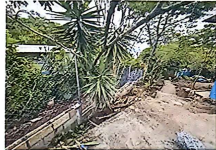
Foto 2: Muro périmetal en construcción para reducir zonas de riesgo.
