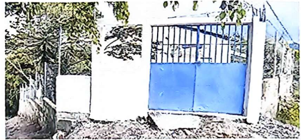
Foto 4: Mejoras realizadas en entrada principal, instalación de portón.
