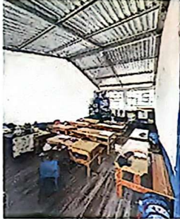
Foto 1: Sustitución de techo de madera por estructura metálica e instalación de cerámica.
