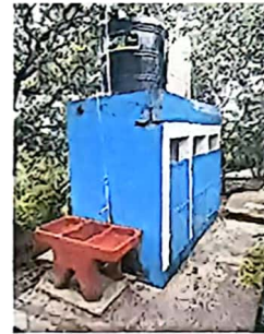
Foto 4: Mejoras realizadas en puertas y baños
