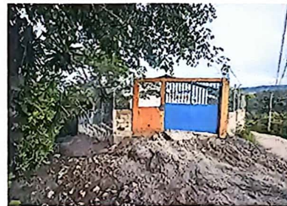
Foto 6: Avances en construcción de muros perimetrales
