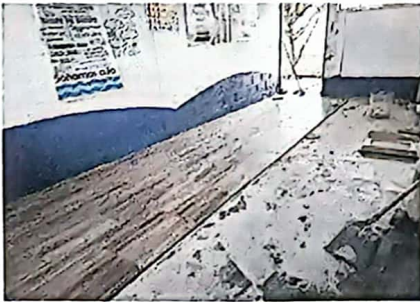
Foto 5: Sustitución de piso de cemento por piso cerámico
