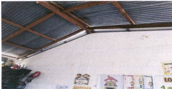
Foto 5: vigas de madera en malas condiciones.
