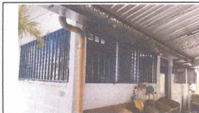
Foto 5: Sustitución de ventanas de malla por estructura de metal
