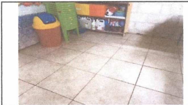
Foto 6: Sustitución de Piso de torta de concreto por piso ceramico
