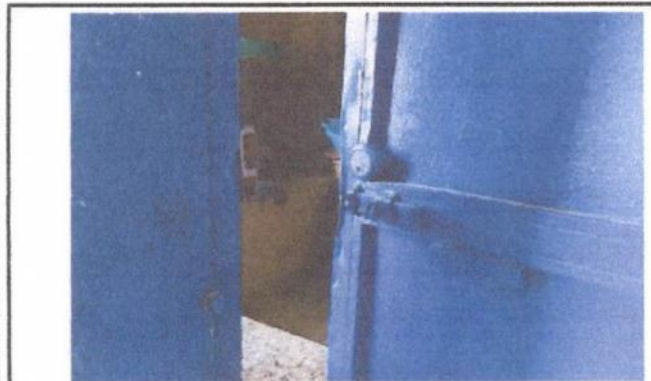
Foto 3: Mantenimiento de estructura de puertas
