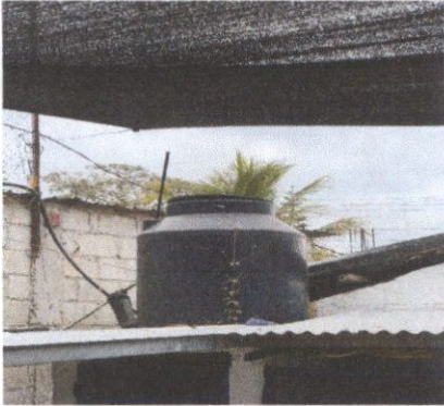
Foto 7: Sustitución de depósito de agua por tinaco
