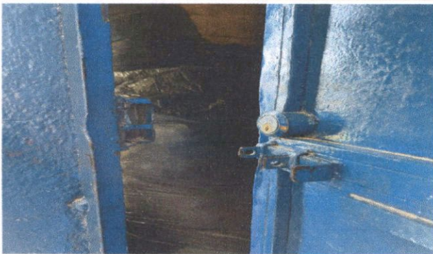
Foto 3: Mantenimiento de estructura de puertas
