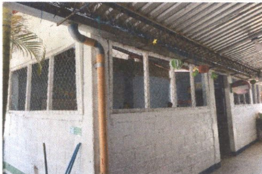
Foto 5: Sustitución de ventanas de malla por estructura de metal
