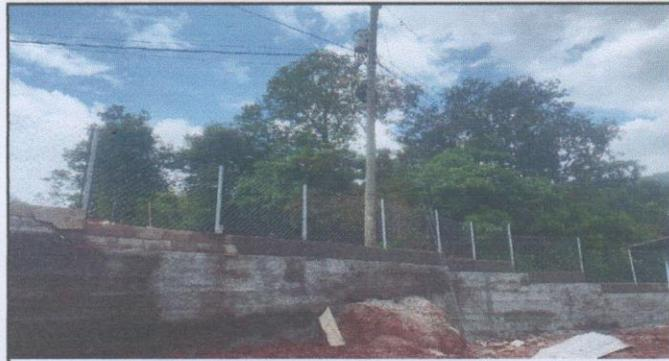
Foto 1: Colocacion de Muro Perimetral y Malla galvanizada
